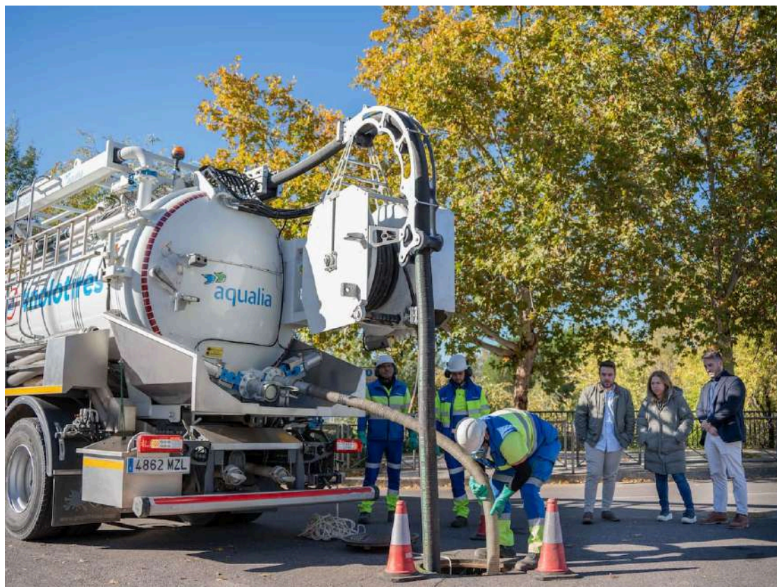
Extracción de residuos en las calles de Mérida / Ayuntamiento de Mérida
